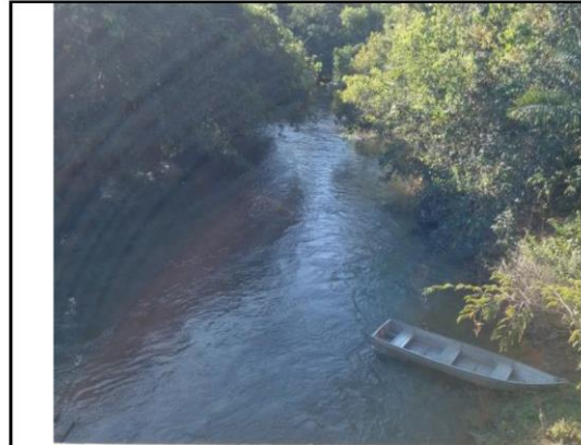
Visto lado Montante da ponte de madeira sobre o Rio Jangada Latitude: 15°11'57.84"S Longitude: 55°19'40.35"O
