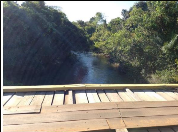
Visto lado Jusante da ponte de madeira sobre o Rio Jangada Latitude: 15°11'57.68"S Longitude: 55°19'40.39"O
