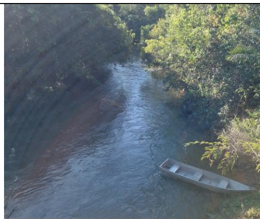
Visto lado Montante da ponte de madeira sobre o Rio Jangada
