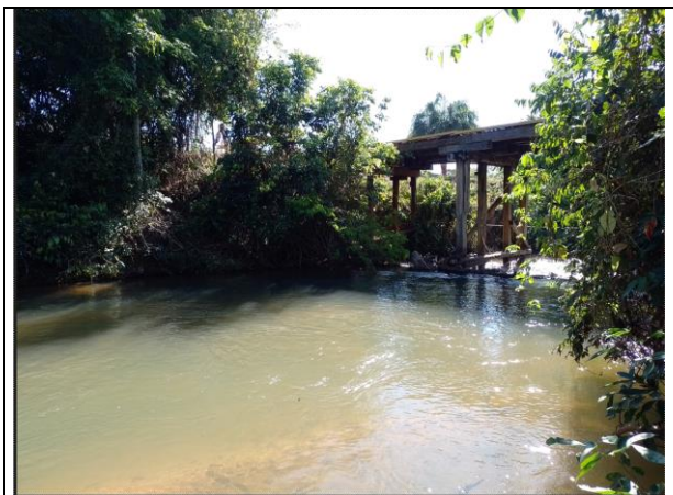
Vista longitudinal da ponte de madeira sobre o Rio Jangada
