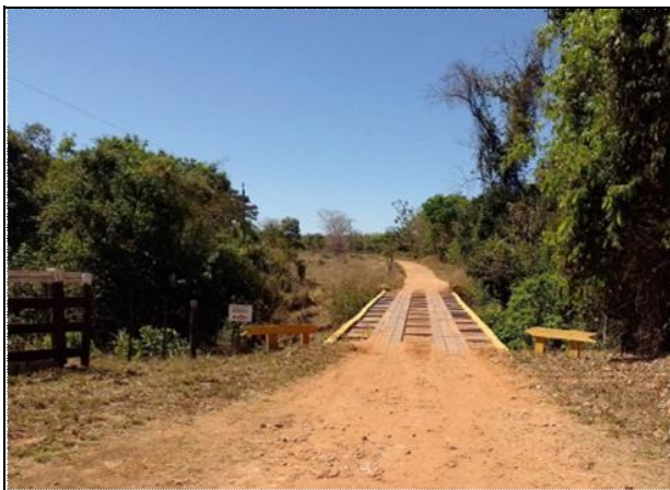
Ponte de Madeira sobre o Rio Jangada
