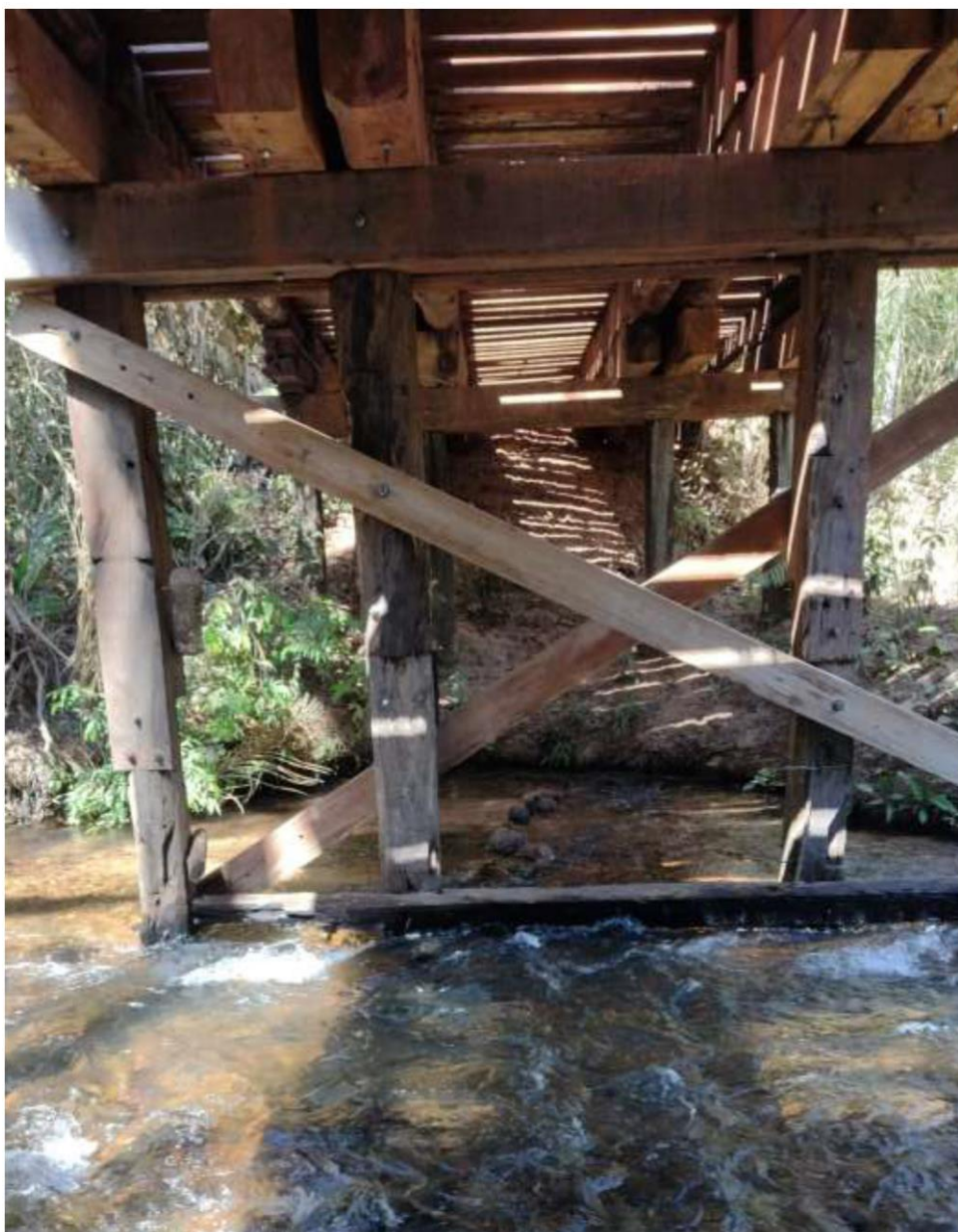
Figura 9 – Vista escoramento da ponte de madeira sobre o Rio Canjirá/Acorá
