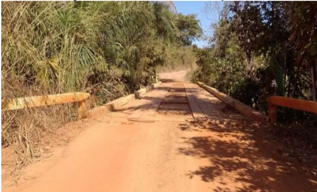
Figura 7 – Ponte de Madeira sobre o Rio Canjira/Acorá
