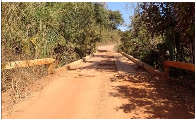
Ponte de Madeira sobre o Rio Canjira/Acorá situada em rodovia municipal
