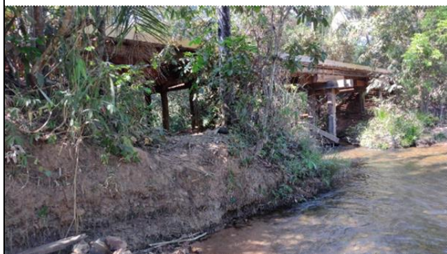
Vista longitudinal da ponte de madeira sobre o Rio Canjira/Acorá vista do tabuleiro na margem do rio
