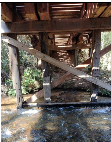
Vista escoramento da ponte de madeira sobre o Rio Canjira/Acorá
