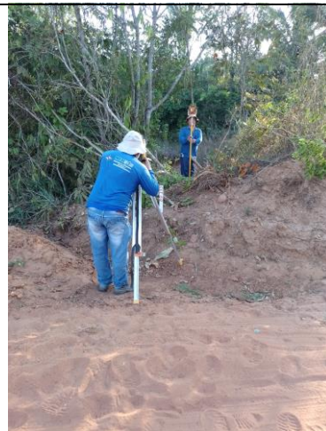
Topografia realizada na região em estudo próximo a ponte de madeira existente sobre o Rio Canjira/Acorá Latitude: 15°14'59.61"S Longitude: 55°39'53.59"O
