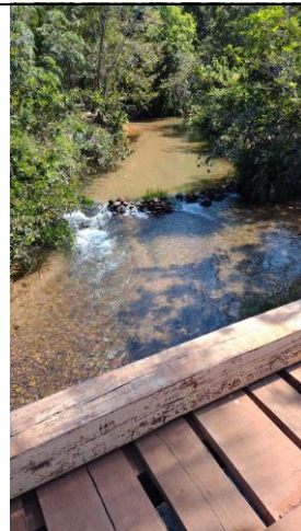
Vista lado Montante da ponte de madeira sobre o Rio Canjira/Acorá Latitude: 15°15'0.15"S Longitude: 55°39'53.73"O
